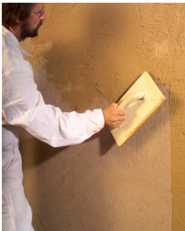
Abbildung 6.1.3: Sorgfältiges Einarbeiten der Armierung mit dem Schwammbrett
