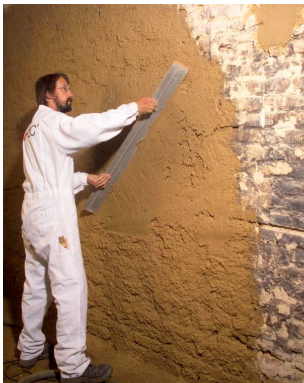
Abbildung 6.1.2: Grobes Abziehen der frischen Putzfläche mit dem Aluminium-Richtscheit
