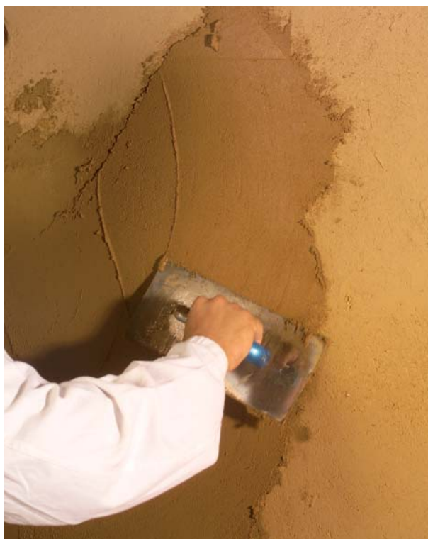
Abbildung 6.1.4: Nach der Trocknung Auftrag von Lehm-Oberputz fein mit dem Edelstahlglätter, Auftragsdicke 2-3 mm
