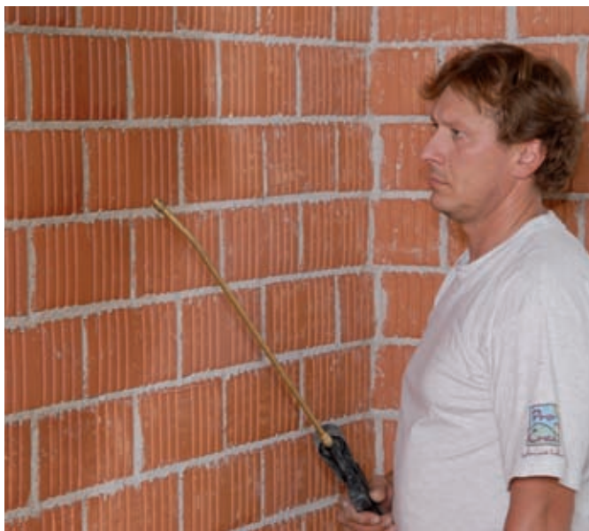
Der Auftrag einer Fluatlösung schützt vor dem Durchschlagen der Fugen bei frischem Mauerwerk.
