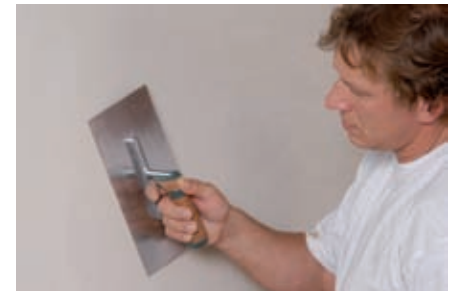
Die Bearbeitung des Lehm-Edelputzes mit der Traufel ergibt eine sehr glatte Oberfläche.
