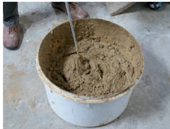
Das Anmischen des Lehmputzes geht gut mit einem Motorquirl.
