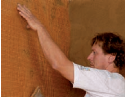
Die Gewebearmierung wird in den frischen Lehmputz eingelegt.
