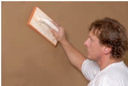
Filzen des ProCrea® Lehm-Oberputzes mit einem groben Schwambrett.
