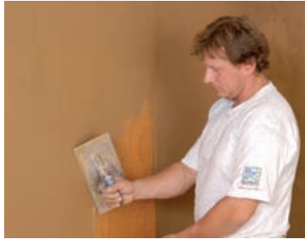
Mit der Traufel wird das Gewebe in den Putz gedrückt.
