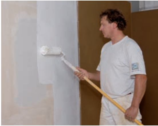
Auftrag der Grundierung mit einer Rolle.
